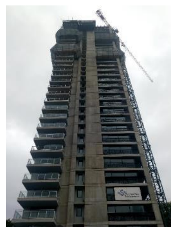
Vista De la obra desde Av. Huergo
