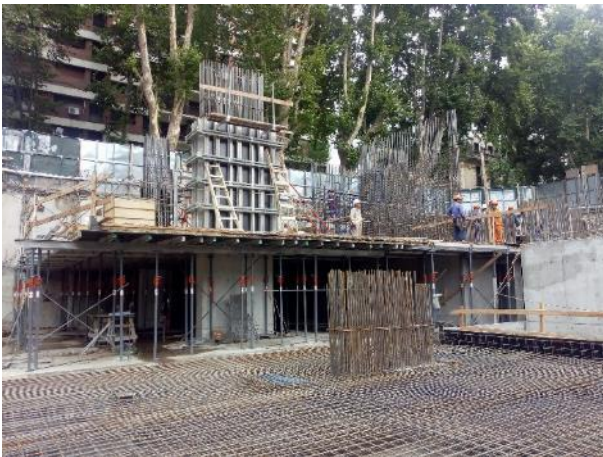
Armado de losa s/3 ss, con las armaduras de columnas y tabiques en espera. Además, se observa el armado de losa s/2ss sector Azopardo
