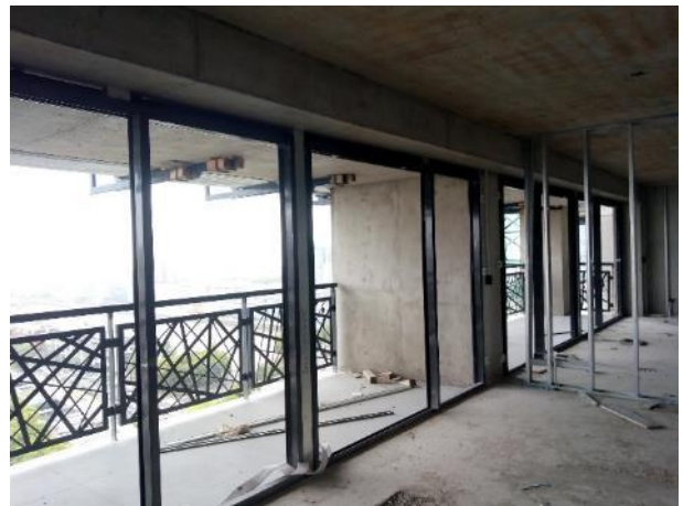
Colocación de carpinterías de aluminio en el piso 25
