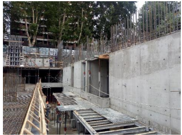
Se observan los tabiques de ascensores
