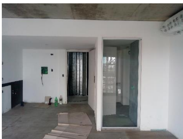
Colocación de frente vidriado de ducha en piso 10
