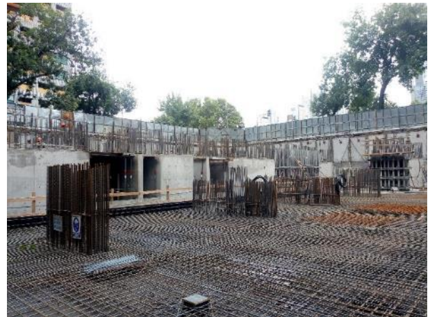
Armado de losa s/3 ss, con las armaduras de columnas y tabiques en espera. Además, se observa el armado de losa s/2ss sector Azopardo
