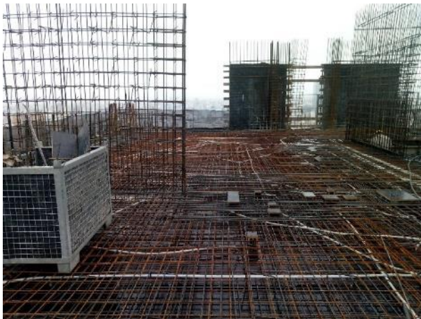
Armadura de losa s/31 sector Ciudad
