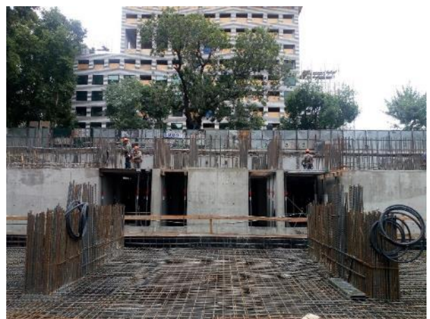
Armado de losa s/2ss sector central
