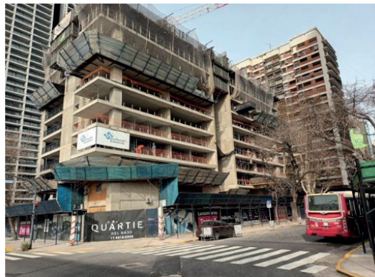
Vista de la obra desde la calle Venezuela Torre 2.
