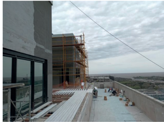
Colocación de piedra bali en piscina y deck en sus alrededores.
