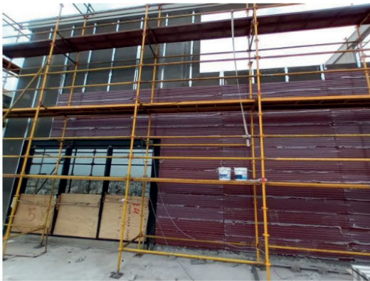
Inicio de colocación de revestimiento metálico en fachada del piso 36.
