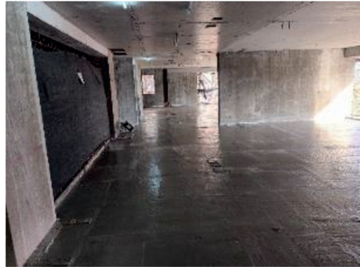
Se realizó la carpeta en piso 6.
