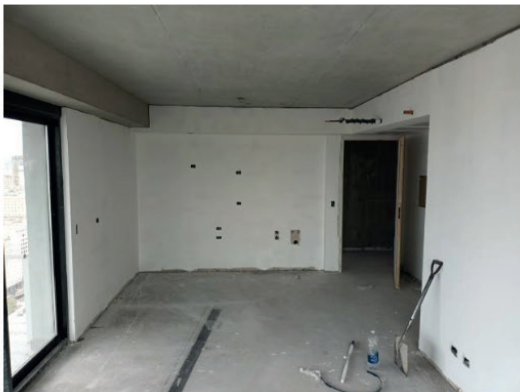
Torre 1: Piso 35, ultimo piso de unidades funcionales con primera mano de pintura.
