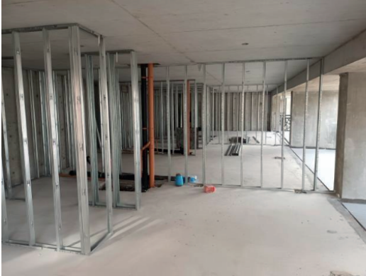
Colocación de estructura de Durlock en piso 5.
