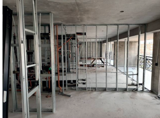
Avanzan las instalaciones sanitarias y eléctricas en piso 3 y 4.
