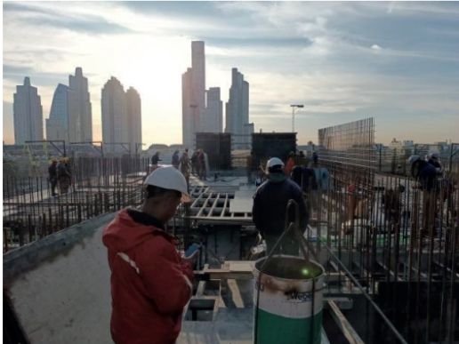
Torre 2: Encofrado de losa sobre 9 piso.
