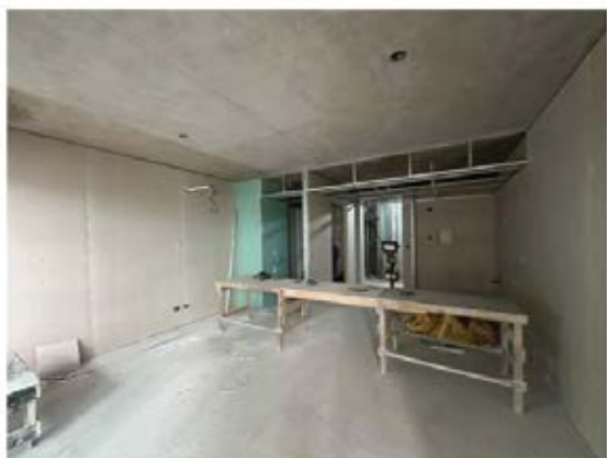
T 2: Armado de cielorraso en piso 17°
