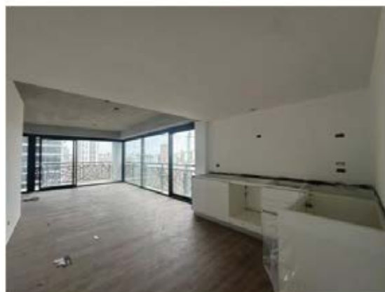
T 2: Armado de muebles de cocina en piso 12°
