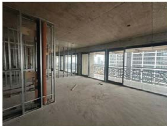
T 2: Colocación de carpintería de aluminio episodio 16
