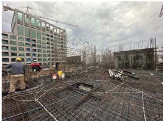
Torre 2: Armado de losa S/31 sector Ciudad
