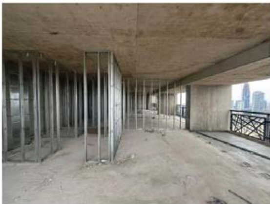
Torre 2: Avance de estructura de durlock en piso 25°
